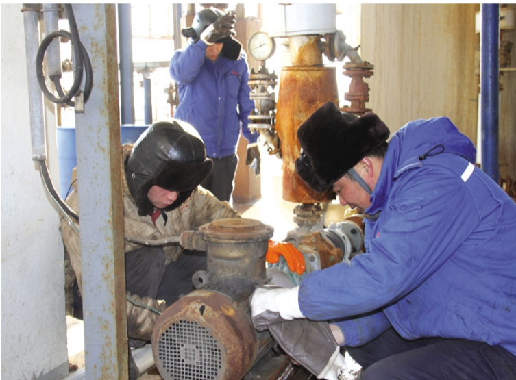
为确保春节期间生产装置安全稳定运行，利海公司加强对工艺设备、管道，特别是室外巡检路线及塔罐的扶梯、平台进行认真检查，做好维护保养，确保人员操作安全。图为大年初一上午设备维护人员对一二氯泵泵进行抢修。（郁洪兵）
