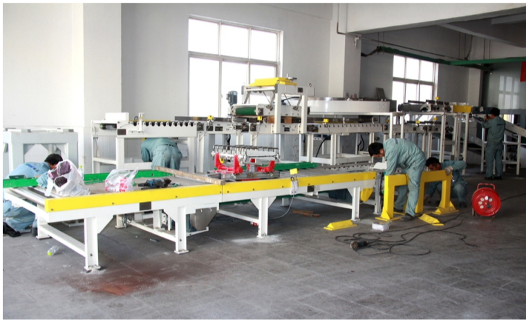
日前，金桥制盐公司50KG机械码垛机安装成功，该项目从去年7月份开始筹备，历经调研、招标、安装、调试等一系列环节，耗资近百万元，此次项目的成功实施，将节约该公司加工盐车间三个班次的人力，进一步实现了降本增效。目前该设备正处于调试阶段，计划于今年五月份投入使用。(万虹羽)
